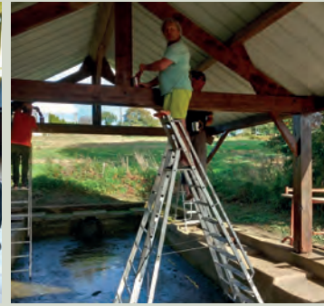
Travaux au lavoir de Pont Croix: ponçage de la charpente et traitement du bois à l'huile de lin
