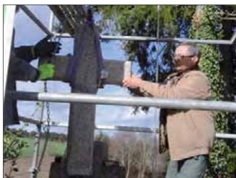
Restauration de la croix de Pont-Croix et de la Ville Hourman
